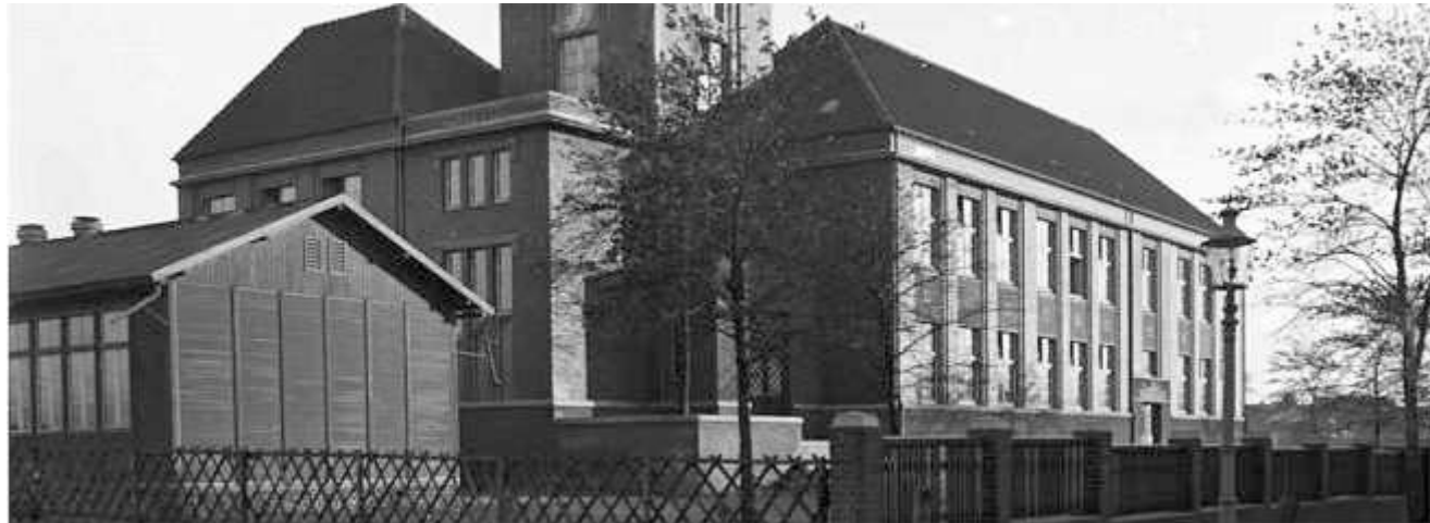
Das Schulbäude an der heutigen Bülser Straße ist immer noch unverkennbar.
